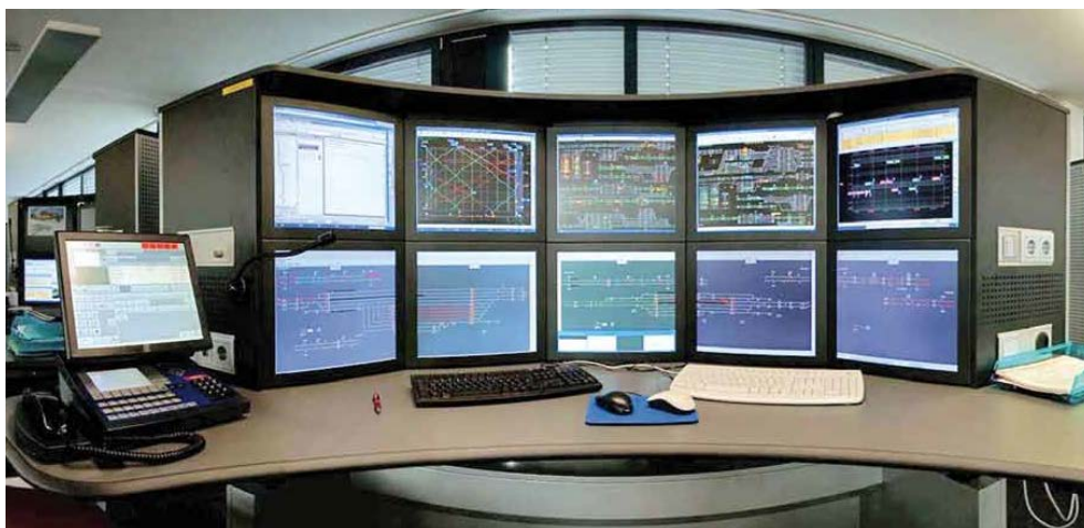
Abbildung 8 – ÖBB Bedienplatz: Zuglenkung mit ARAMIS [11]
